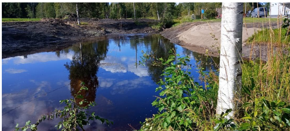
Lampi ruoppauksen jälkeen
